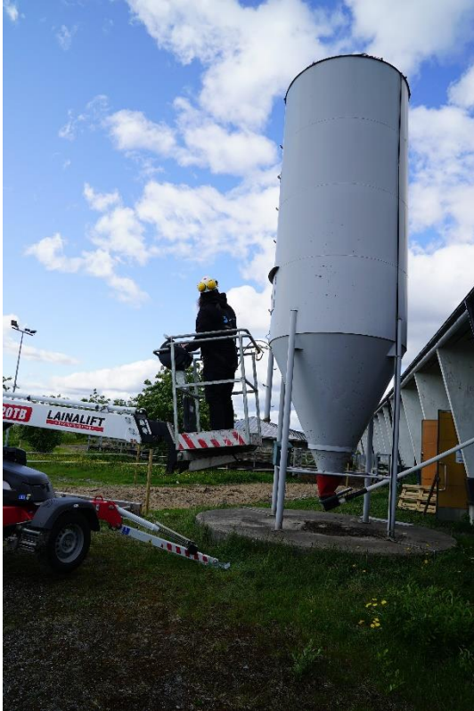
Kuva 1. Anturin siiloon asentaminen käynnissä maatilalla (kuva: Virpi Käyhkö)
