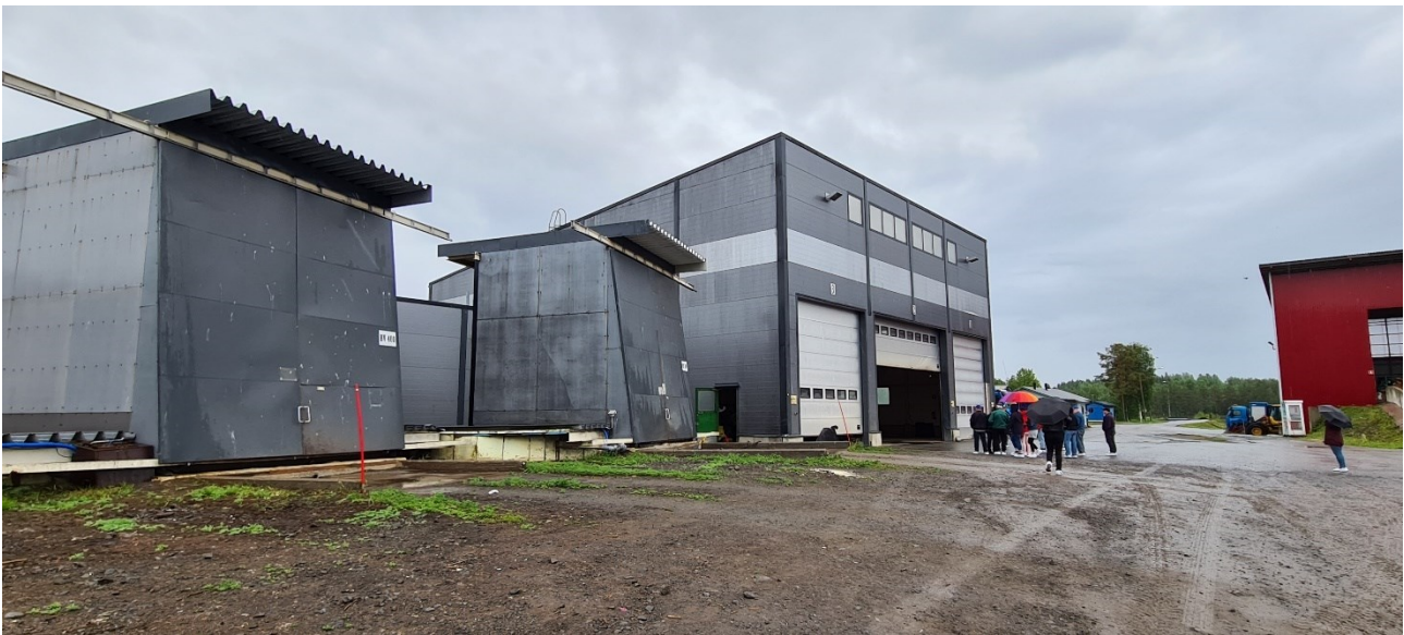
Kuvio 14. Kiteellä sijaitsevan BioKymppin syötteiden vastaanottorakennus. Kuva Mikko Aalto
