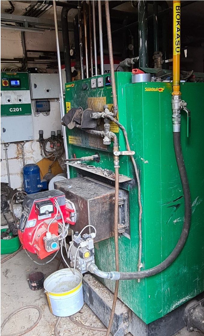
Kuvio 15. Lassi Kähkösen biokaasukäyttöinen lämmityskattila. Kuva Mikko Aalto
