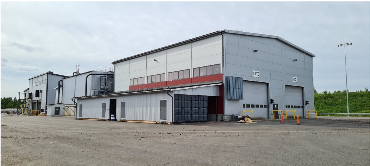
Kuvio 10. Etelä-Karjalan Jätehuollon biokaasulaitos. Etualalla syötteen vastaanottohalli, jossa on erilliset linjat lietteelle ja biojätteelle. Kuva Mikko Aalto
